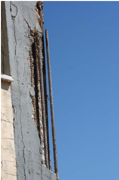
Προσεισμικός έλεγχος: Απόσπαση επικάλυψης και οξείδωση οπλισμού υποστυλωμάτων.
