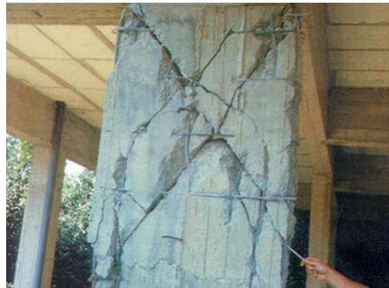
Μετασεισμικός έλεγχος: Ρηγμάτωση υποστυλώματος και τοιχώματος τοιχώματος μετά από ισχυρό σεισμό (αριστ.: Αθήνα, 1999) - δεξ.: Καλαμάτα 1986).
