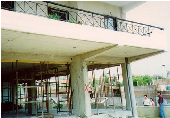
Μετασεισμικός έλεγχος: Ρηγμάτωση υποστυλώματος και τοιχώματος τοιχώματος μετά από ισχυρό σεισμό (αριστ.: Αθήνα, 1999) - δεξ.: Καλαμάτα 1986).
