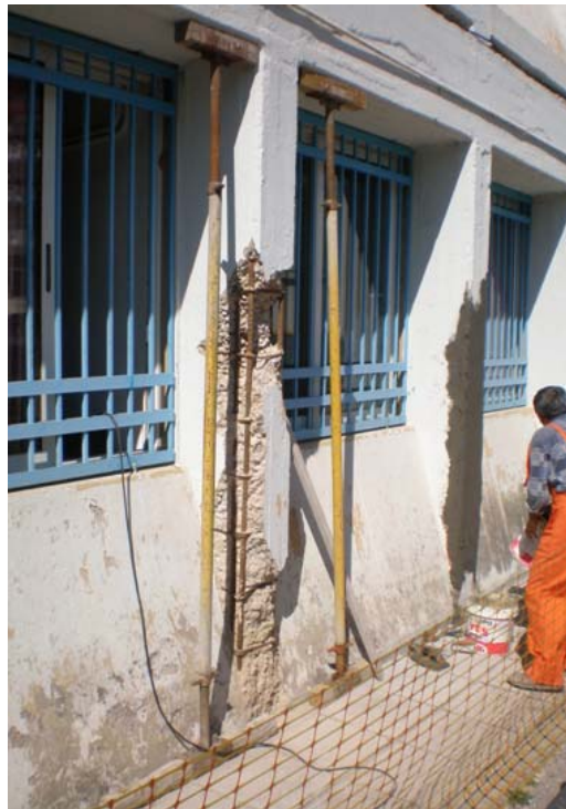
Προσεισμικός έλεγχος: Απόσπαση επικάλυψης και οξείδωση οπλισμού υποστυλωμάτων.
