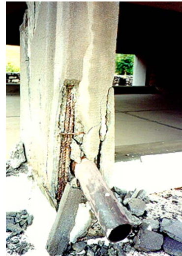
Συνέπειες κοντού υποστυλώματος σε συνδυασμό με ανεπαρκή όπλιση και κακοτεχνία (Κόνιτσα 1996).
