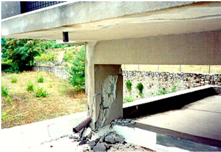
Συνέπειες κοντού υποστυλώματος σε συνδυασμό με ανεπαρκή όπλιση και κακοτεχνία (Κόνιτσα 1996).
